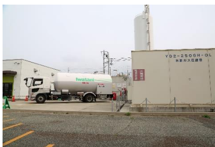
発電施設の燃料タンクに充填
